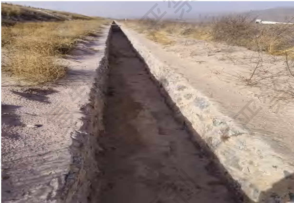
图 2.4-4 坝面纵向排水沟
