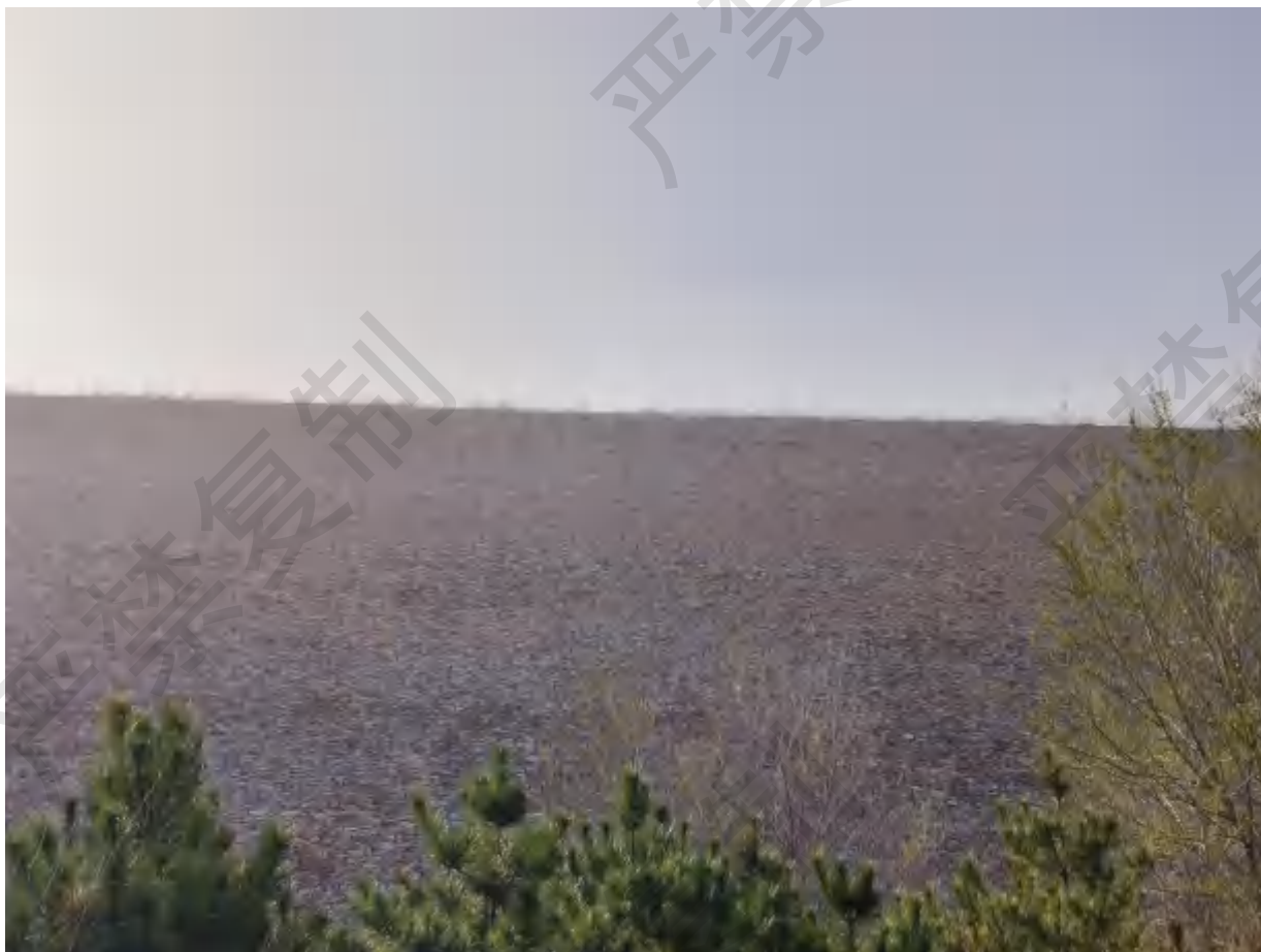
图 2.4-1 初期坝外坡面
