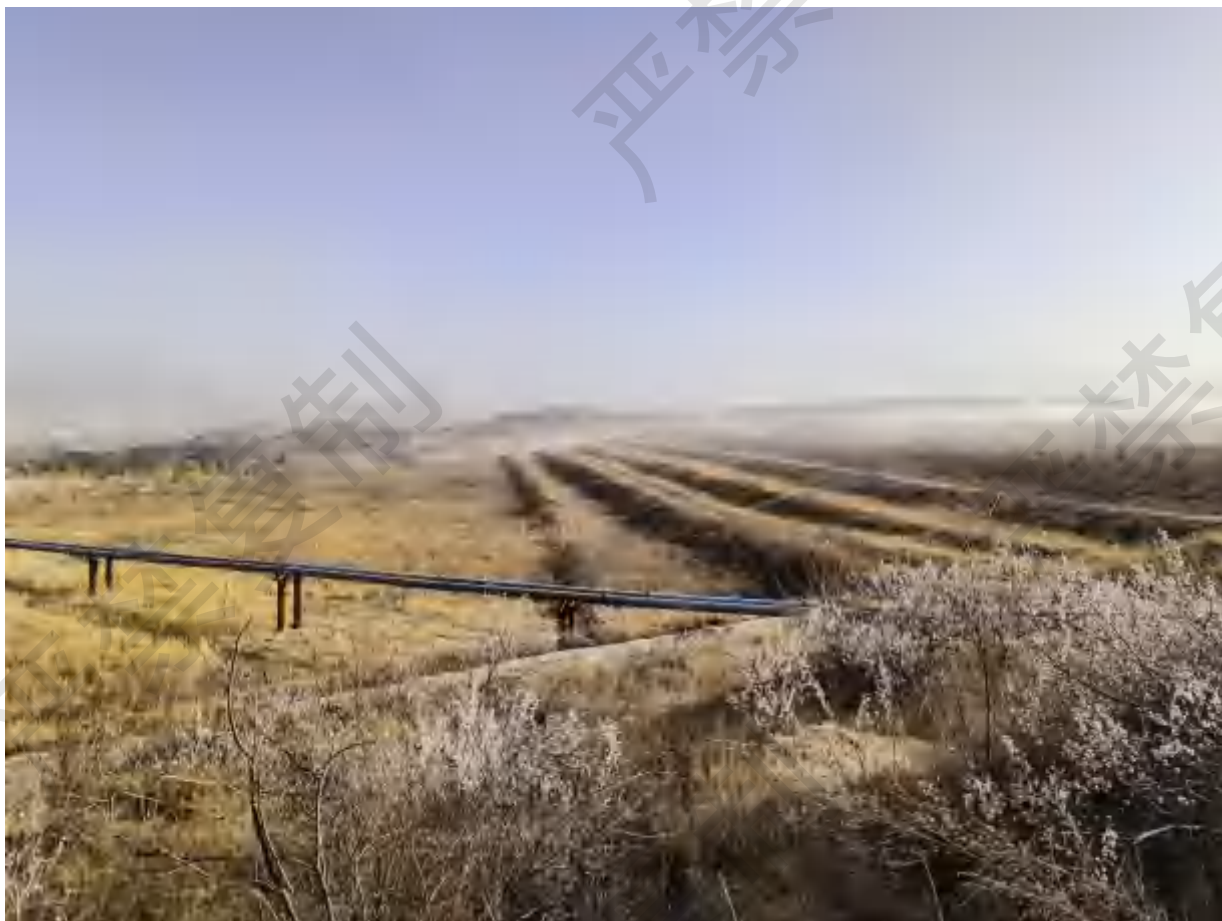
图 2.4-3 堆积坝外坡面
