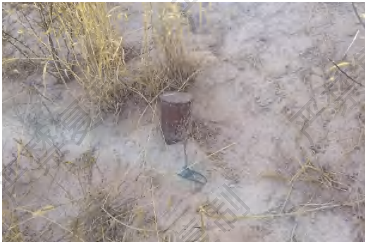
图 2.4-9 人工浸润线观测设施
